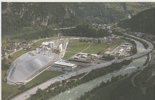
Nella foto sopra: vista panoramica del cantiere di Amsteg.
