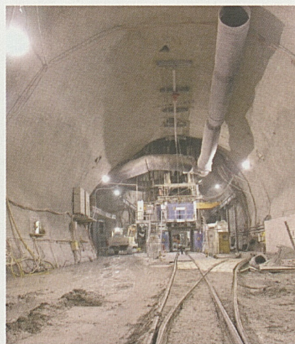
Nella foto sopra: Lavori in galleria al cantiere di Sedrun, ai piedi del pozzo.
