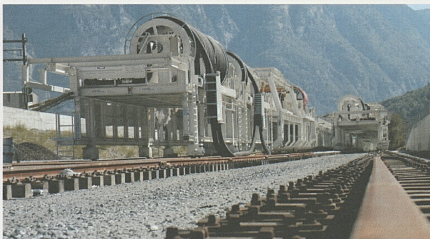
Foto sopra: i macchinari per il rivestimento finale della Galleria di base del San Gottardo sono pronti per l'entrata dal portale.
