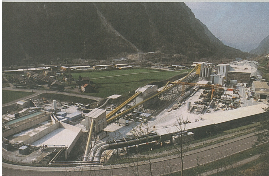
Foto: panoramica del cantiere di Amsteg.
