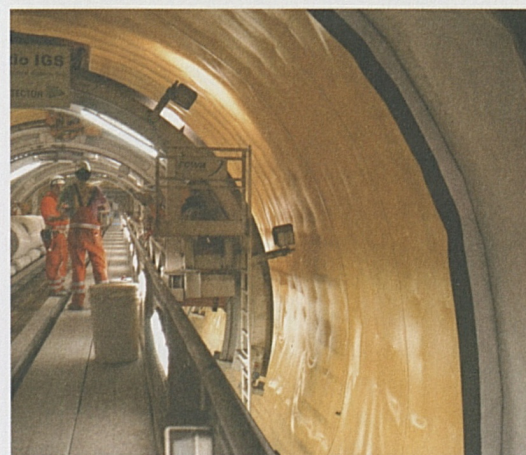
Foto sopra: lavori in galleria a Bodio.
