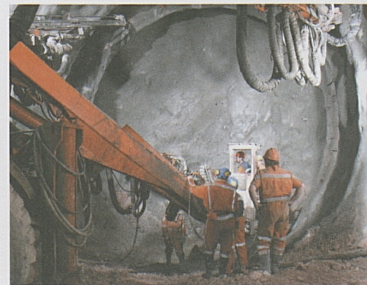
Foto sotto: lavori di avanzamento a Sedrun.
