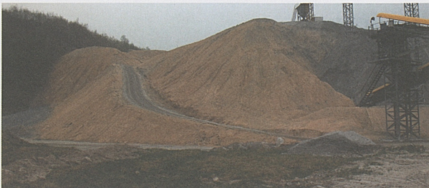
Foto sotto: dettaglio del deposito della Buzza di Biasca coperto dalla guaina vegetale antipolvere.
