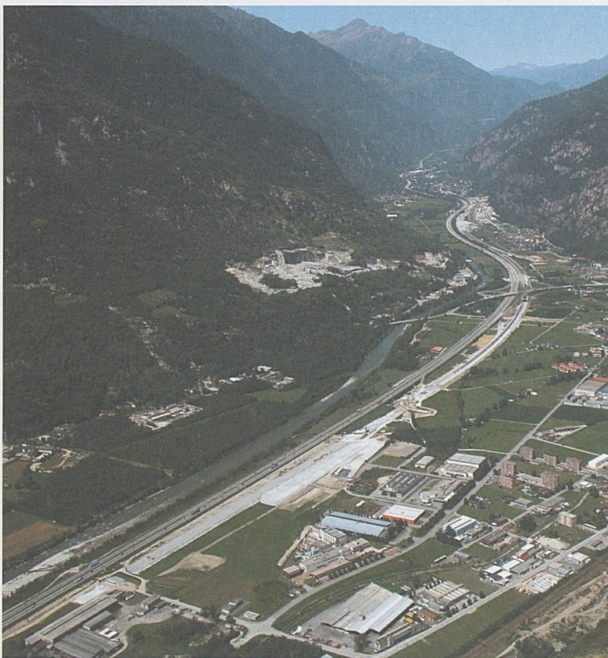
Foto sopra: panoramica dei lavori a cielo aperto nella zona di Biasca.
