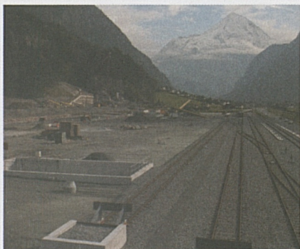
Foto sopra: panoramica del posto d'installazione.
