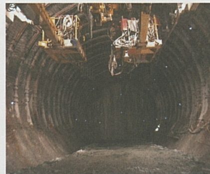
Foto sopra: avanzamento nella roccia spingente.
