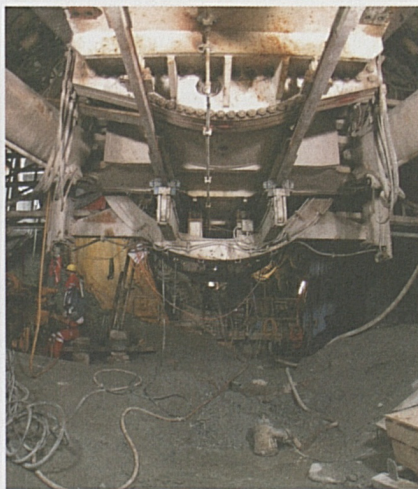
Foto sopra: fresatrice Gabi II bloccata nel tubo ovest.
