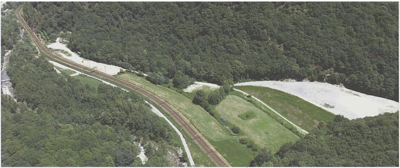
Foto sopra: Panoramica del cantiere di Sigirino.
