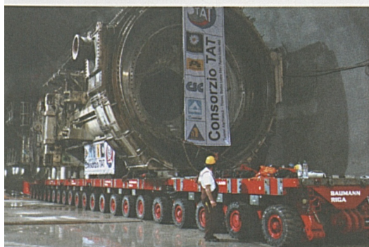
Foto sopra: spostamento della fresa nel tubo ovest. Foto sotto: fresa nel tubo ovest durante lo smontaggio.
