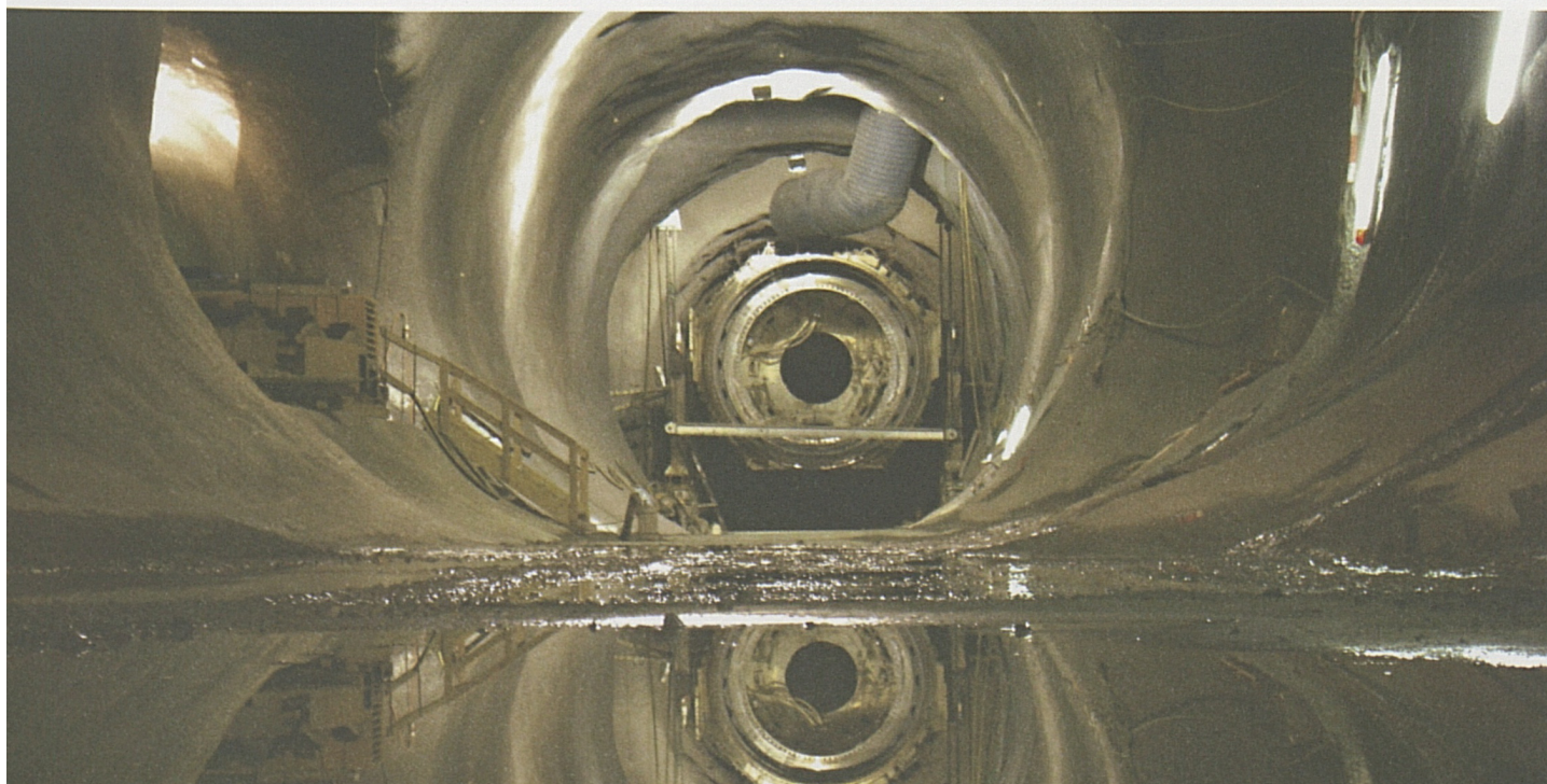
Foto sopra: spostamento della fresa nel tubo ovest. Foto sotto: fresa nel tubo ovest durante lo smontaggio.
