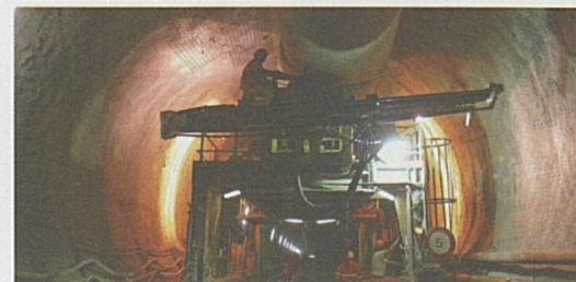
Tubo est: lavori di rivestimento.
