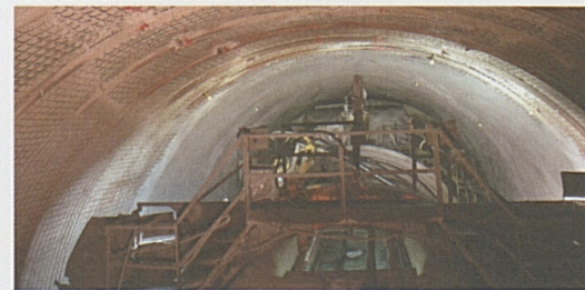
Tubo est: lavori di rivestimento.
