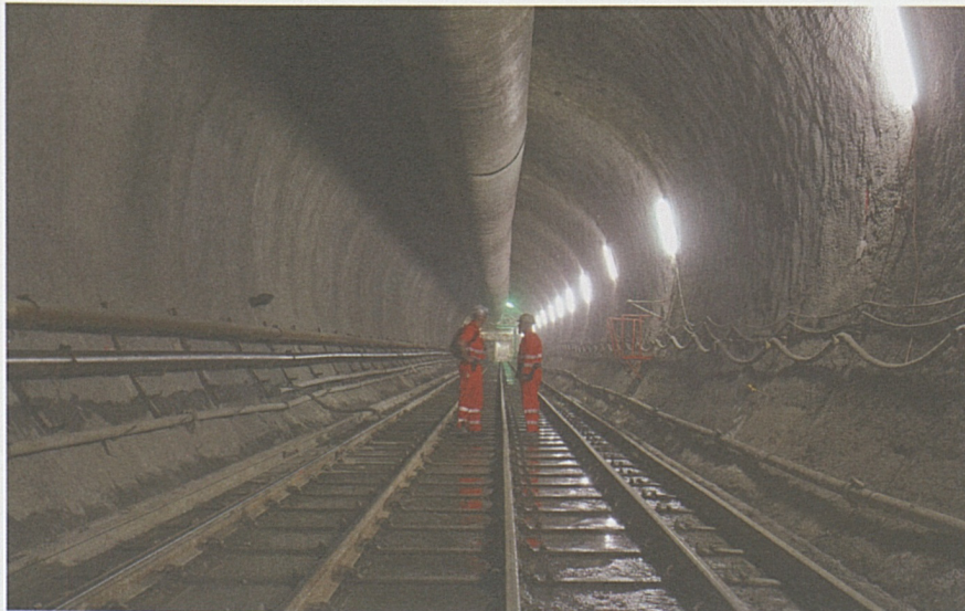
Tubo ovest: tecnici al lavoro.
