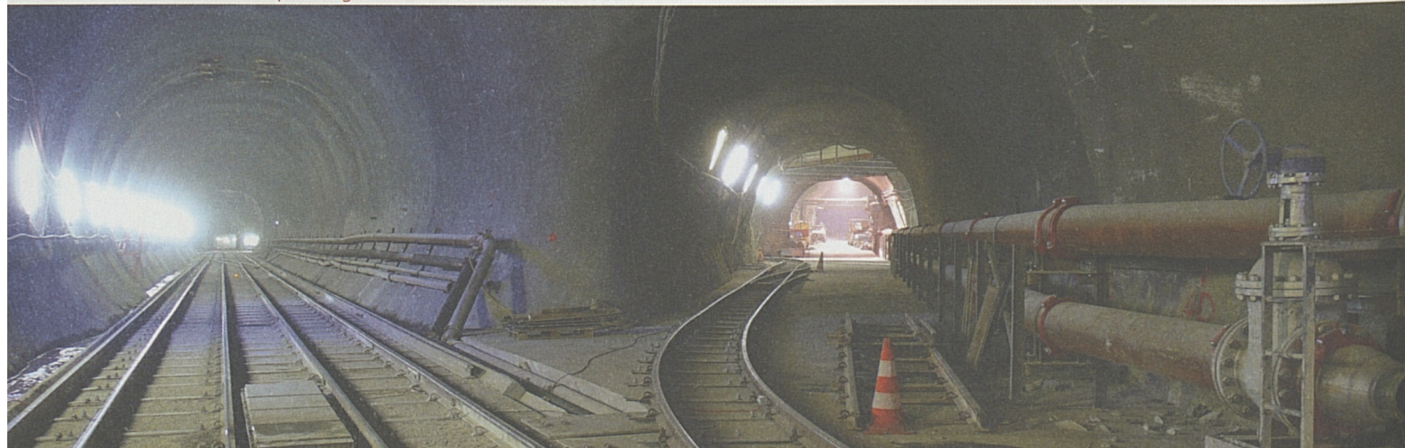
Carota: gneis ricco di mica. Galleria a binario unico per usi logistici del cantiere.
