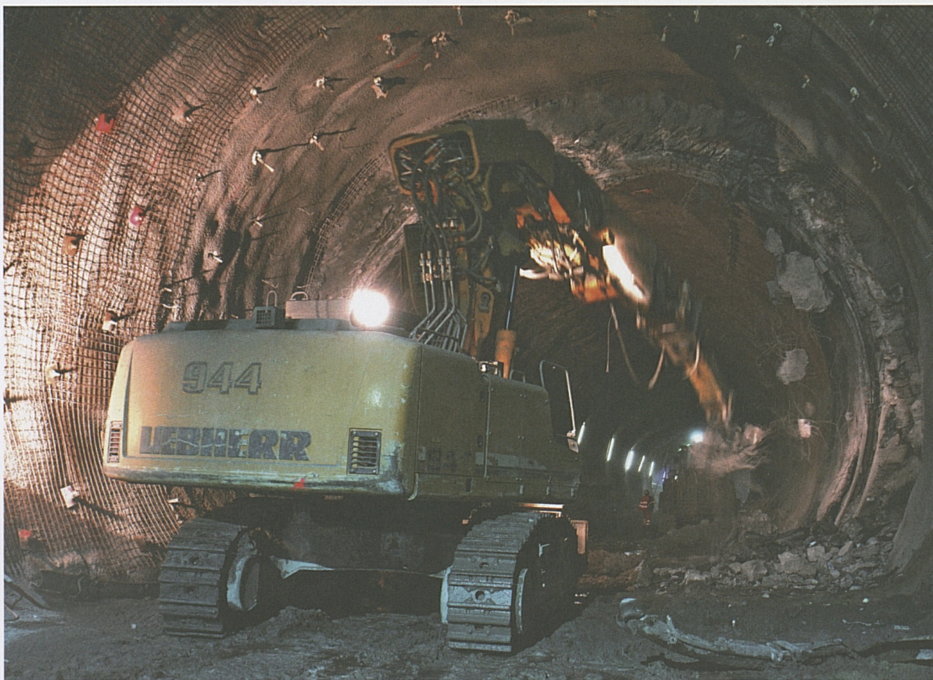
L'elevata profondità del tunnel, e la conseguente enorme pressione sulla roccia, possono anche generare significative deformazioni della volta, come qui nella Stazione multifunzionale di Faido.
