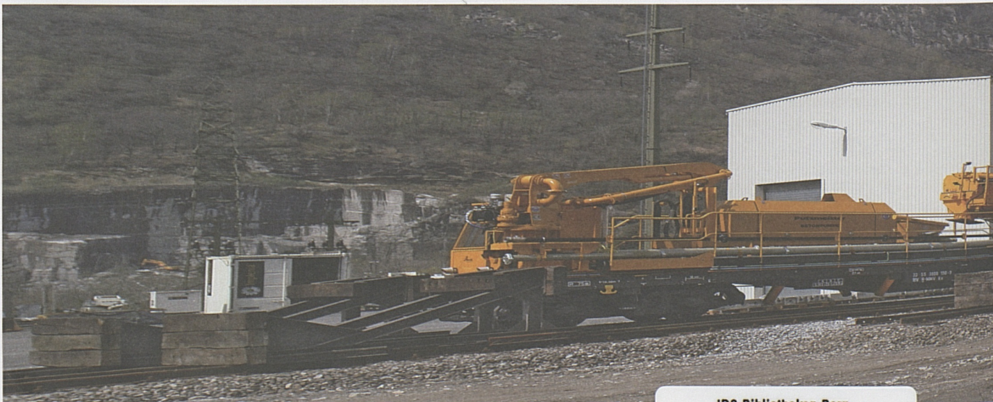
Il treno speciale che permetterà di produrre (e posare) il calcestruzzo della platea direttamente in galleria.
