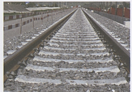
Binari e traversine sul tracciato a cielo aperto a Biasca.
