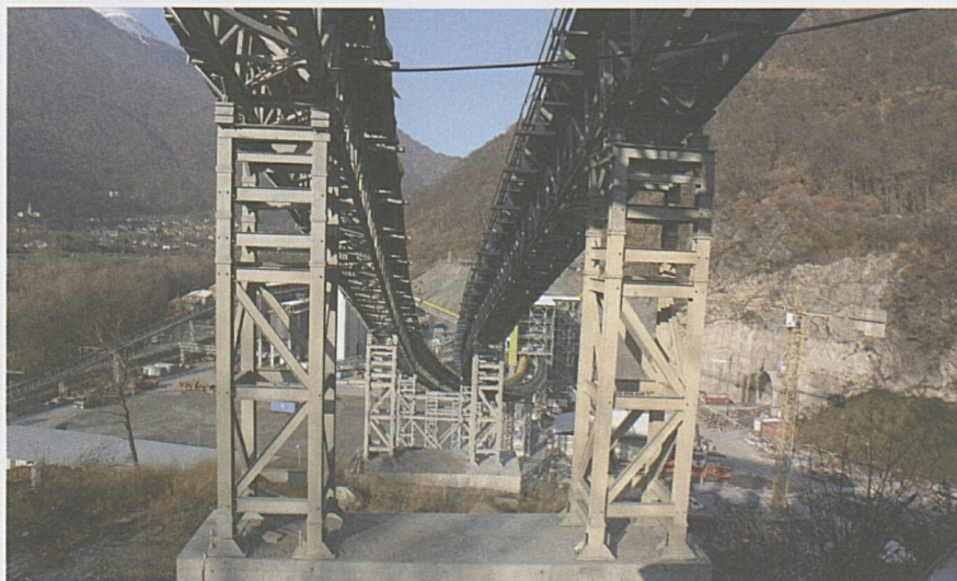
Un imponente sistema di nastri trasportatori indirizza gran parte del materiale direttamente verso la sua destinazione finale.
