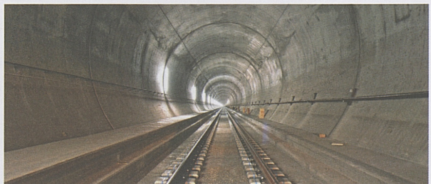
Galleria con binari definitivi nel tubo ovest tra Bodio e Faido.
