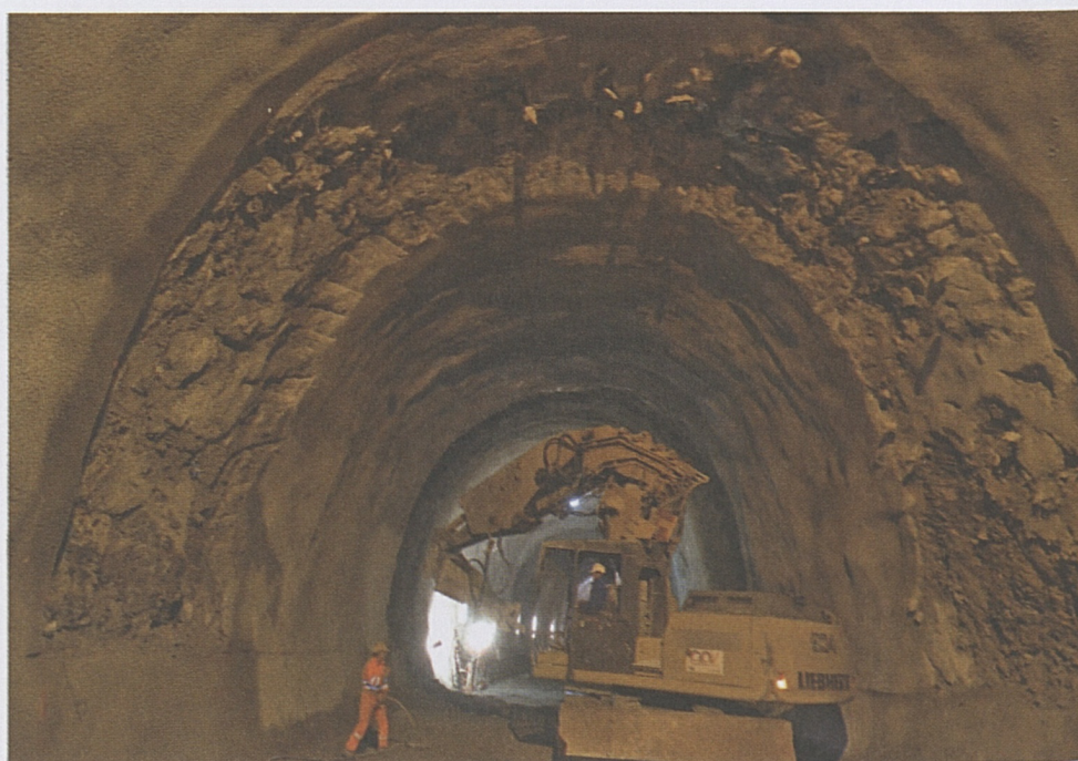
Vezia: tubo est, direzione nord
