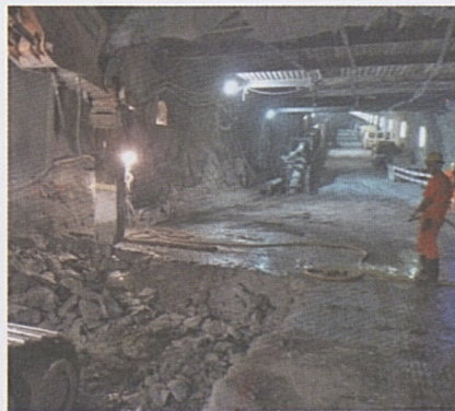
Demolizione della soletta provvisoria nella caverna trasversale.
