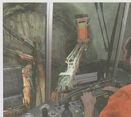
Galleria di base del Ceneri, lavori in galleria: prove su calcestruzzo e attività di perforazione
