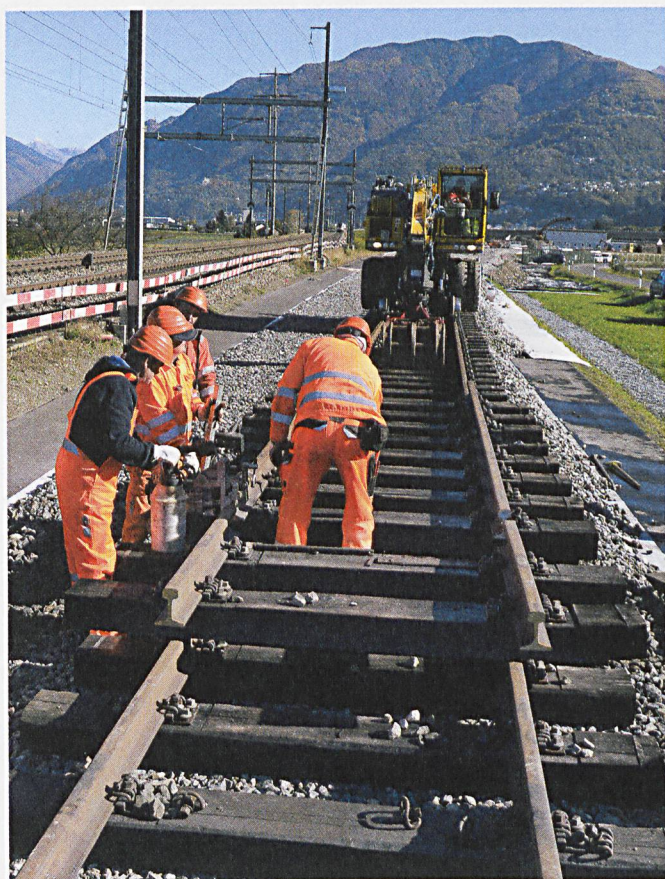
Posa binari di servizio.
