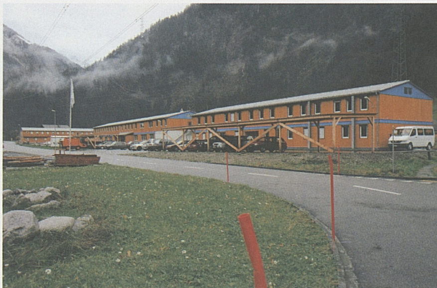
Die Bürogebäude der AlpTransit Gotthard AG, der örtlichen Bauleitung und der ARGE AGN.
