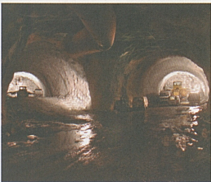
Ausbruch der Multifunktionsstelle Faido.
