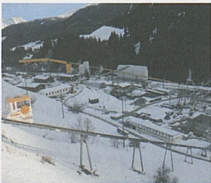
ATG-Baustelle Sedrun im Winterkleid.
