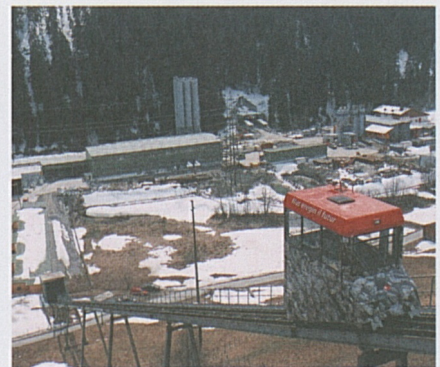
Installationsplatz Las Ruera in Sedrun.
