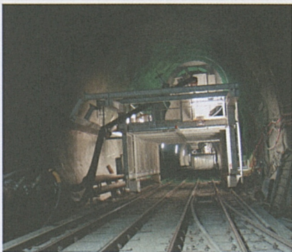
Oströhre des Gotthard-Basistunnels in Bodio.
