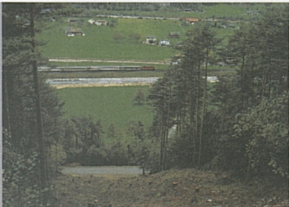
Rodungen im Bereich des Brauchwasserreservoirs.
