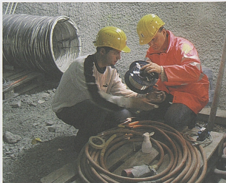
Kontrollmessung der Glasfaserkabel auf der NEAT-Baustelle Amsteg.
