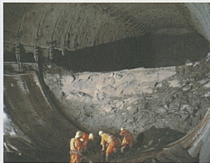
Komplexe Ausbrucharbeiten in Faido.
