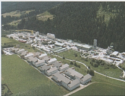
Luftaufnahme von der ATG-Baustelle Sedrun.
