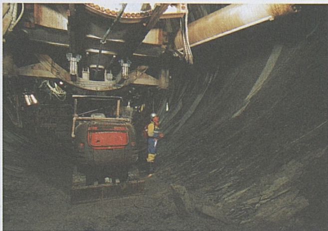
Kontrollgang der örtlichen Bauleitung zum Vortrieb.
