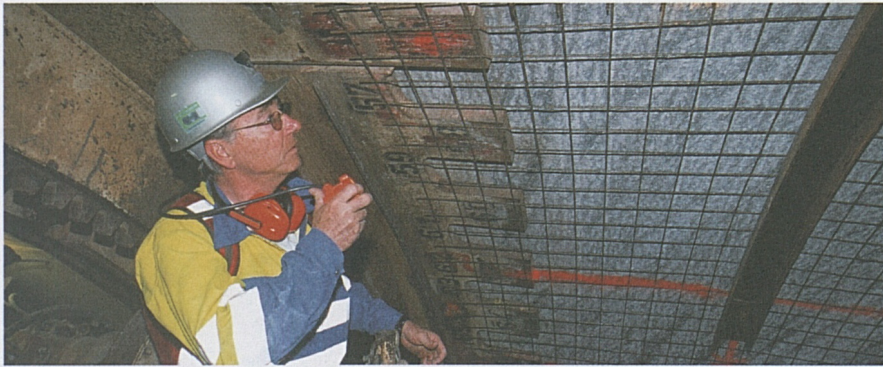
Chefbauleiter Claude Genoud an vorderster Front auf der Tunnelbohrmaschine ...
