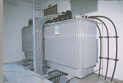
Der 50/15 kV-Transformator im Kraftwerk Arniberg wurde im Hinblick auf die NEAT-Baustromversorgung komplett revidiert.
