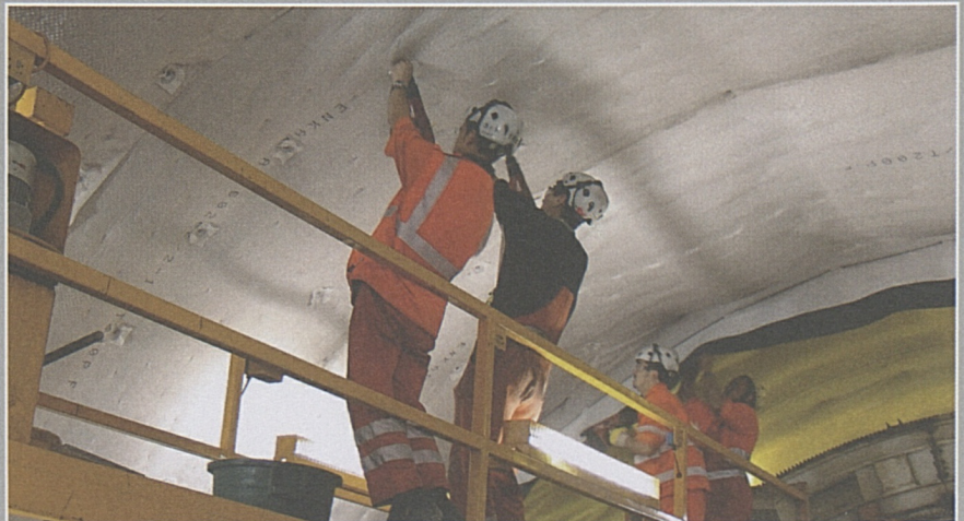
Bodio – Mineure beim Befestigen von Abdichtungsmatten in der Oströhre.
