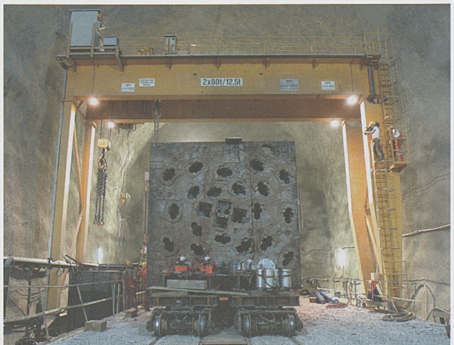
Die Demontage der beiden Amsteger Tunnelbohrmaschinen schreitet zügig voran.
