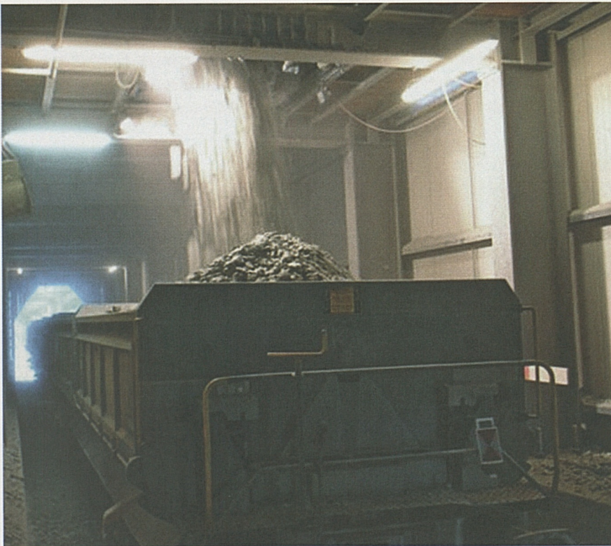
2,4 Millionen Tonnen Material wurden in 2400 Zügen von Amsteg nach Flüelen transportiert.
