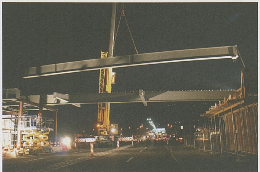
Eine provisorische Brücke soll die Kantonsstrasse vom Baustellenverkehr entlasten.
