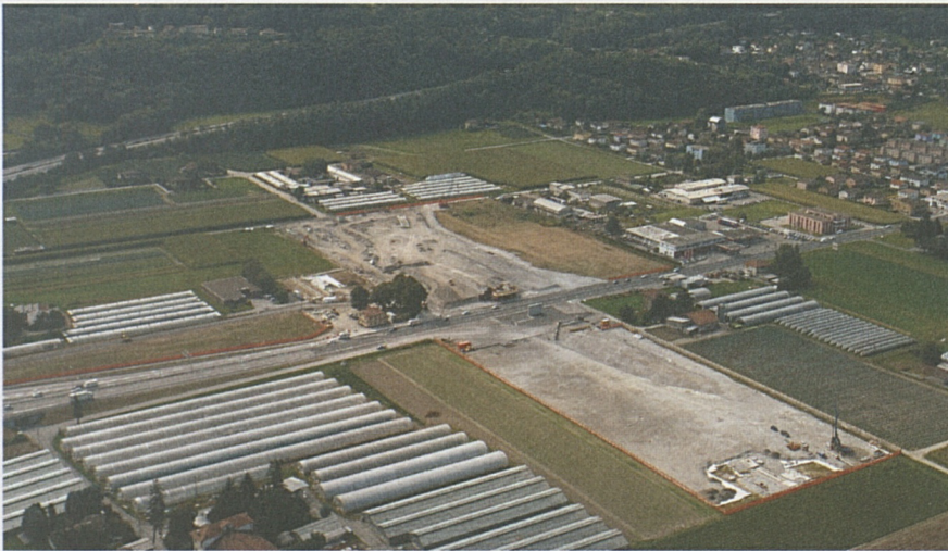
Die Baustelle in Camorino aus der Vogelperspektive.
