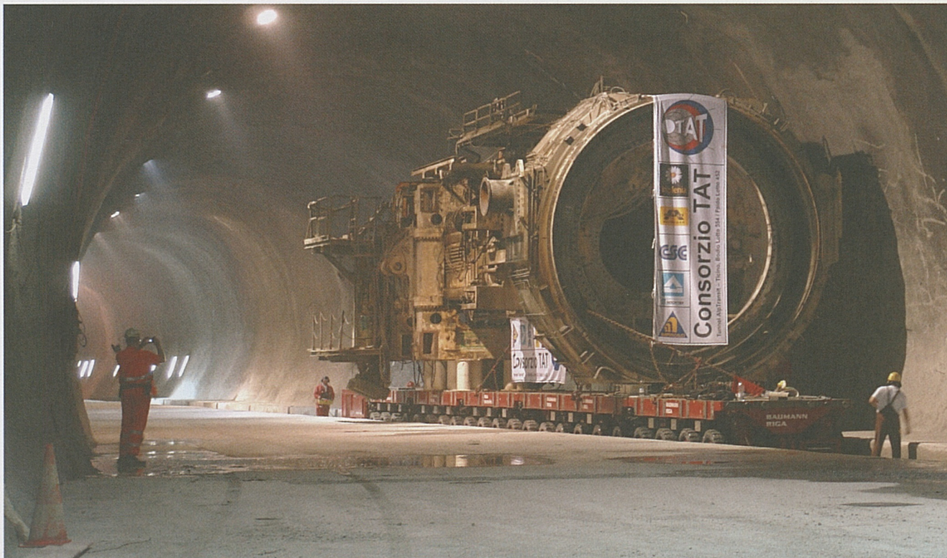
Die Tunnelbohrmaschinen wurden demontiert und in die Montagekavernen am Nordende transportiert.
