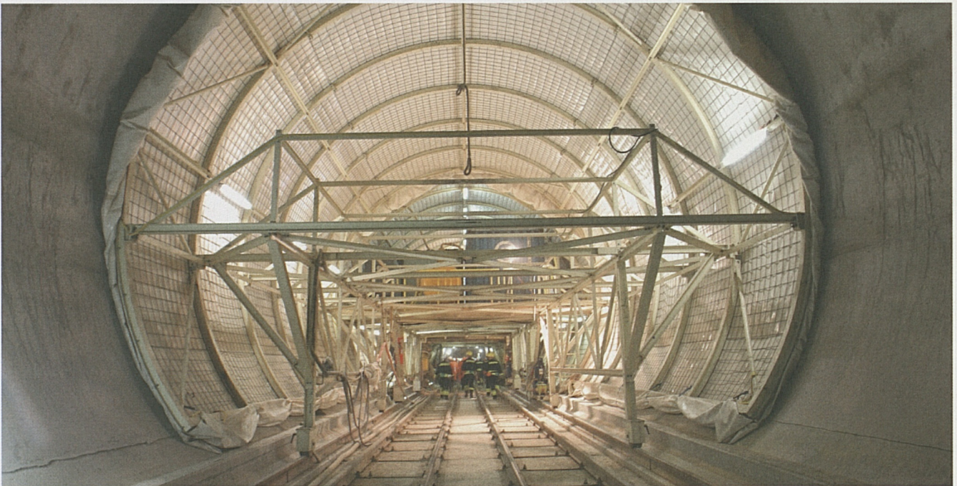
Sedrun: In der Multifunktionsstelle entsteht die Innenschale.
