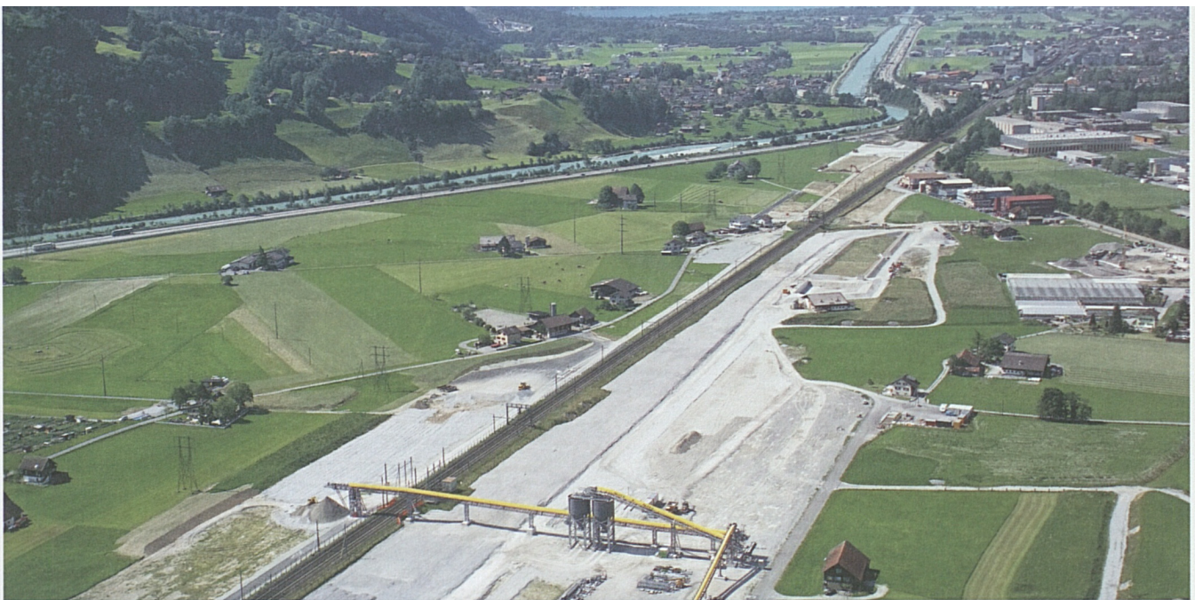
Blick Richtung Norden: Der Teilabschnitt Altdorf/Rynächt mit der offenen Strecke im nördlichen Teil.
