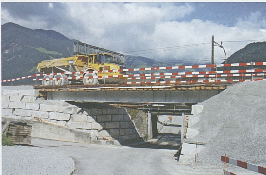
Bestehende Unterführung Riedstrasse: Hilfsbrücke für Mulden-Dumper.
