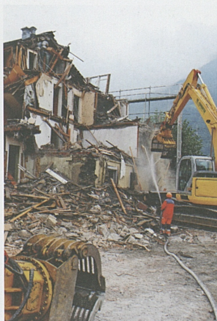
Abbrucharbeiten am Restaurant Walter Fürst.
