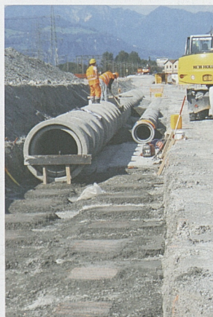
Verlegen von Trasse- und Bergwasserleitungen.
