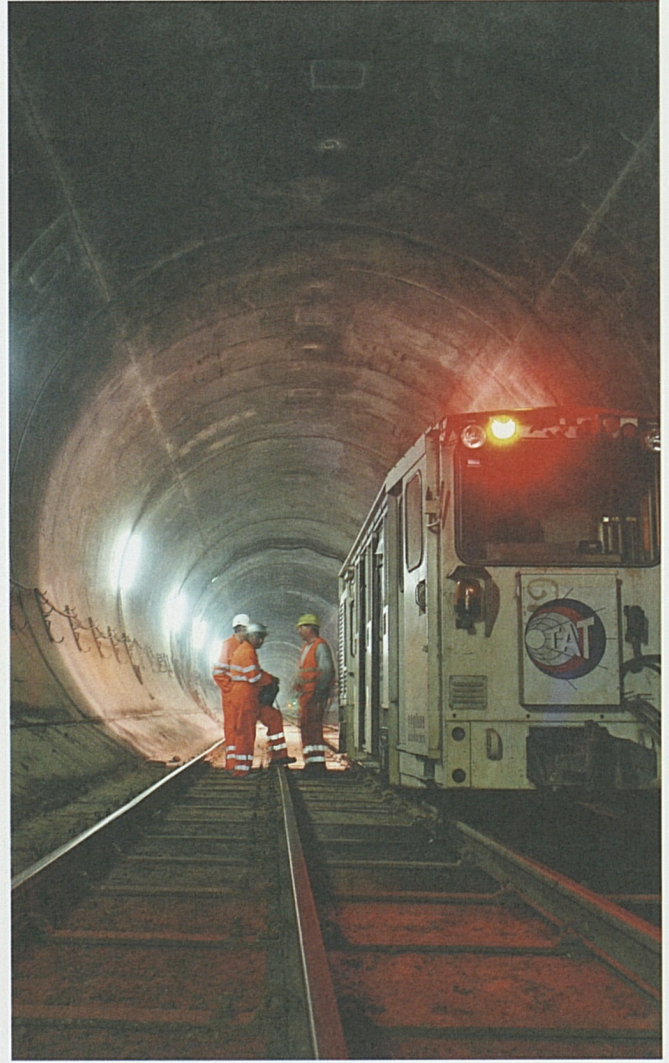
Bodio: Blick in die Weströhre mit Stollenbahn und Mineuren.
