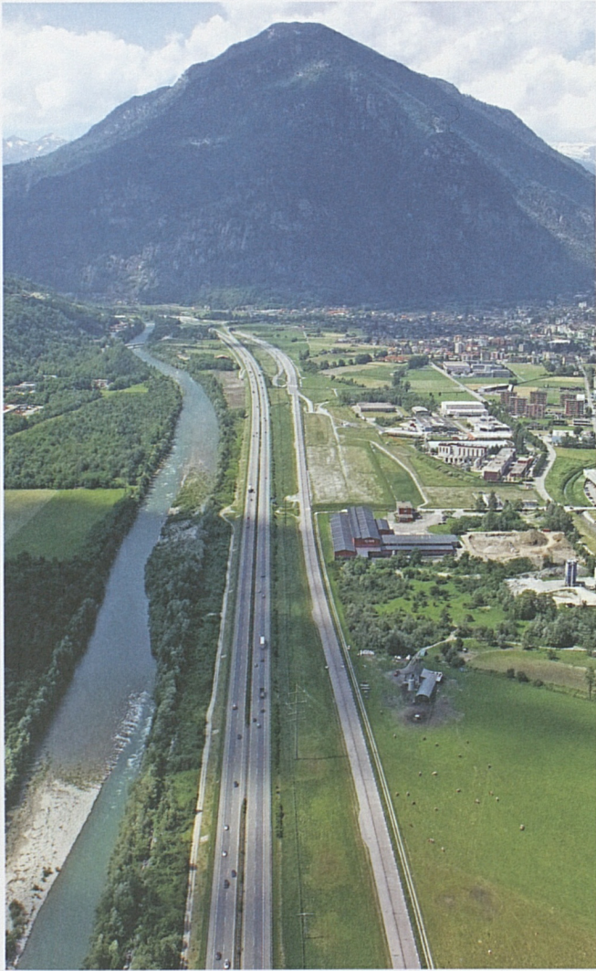
Biasca: Die neu erstellte, offene Strecke rechts der Autobahn Richtung Norden.
