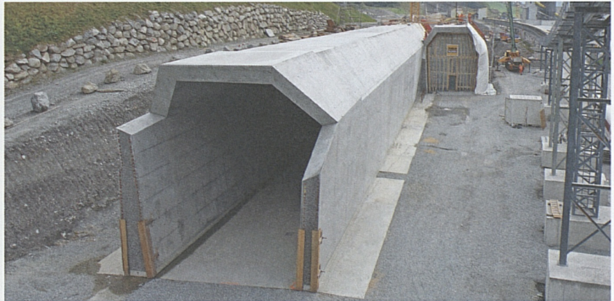
Erstfeld – Tagbautunnel Ost links und West rechts.
