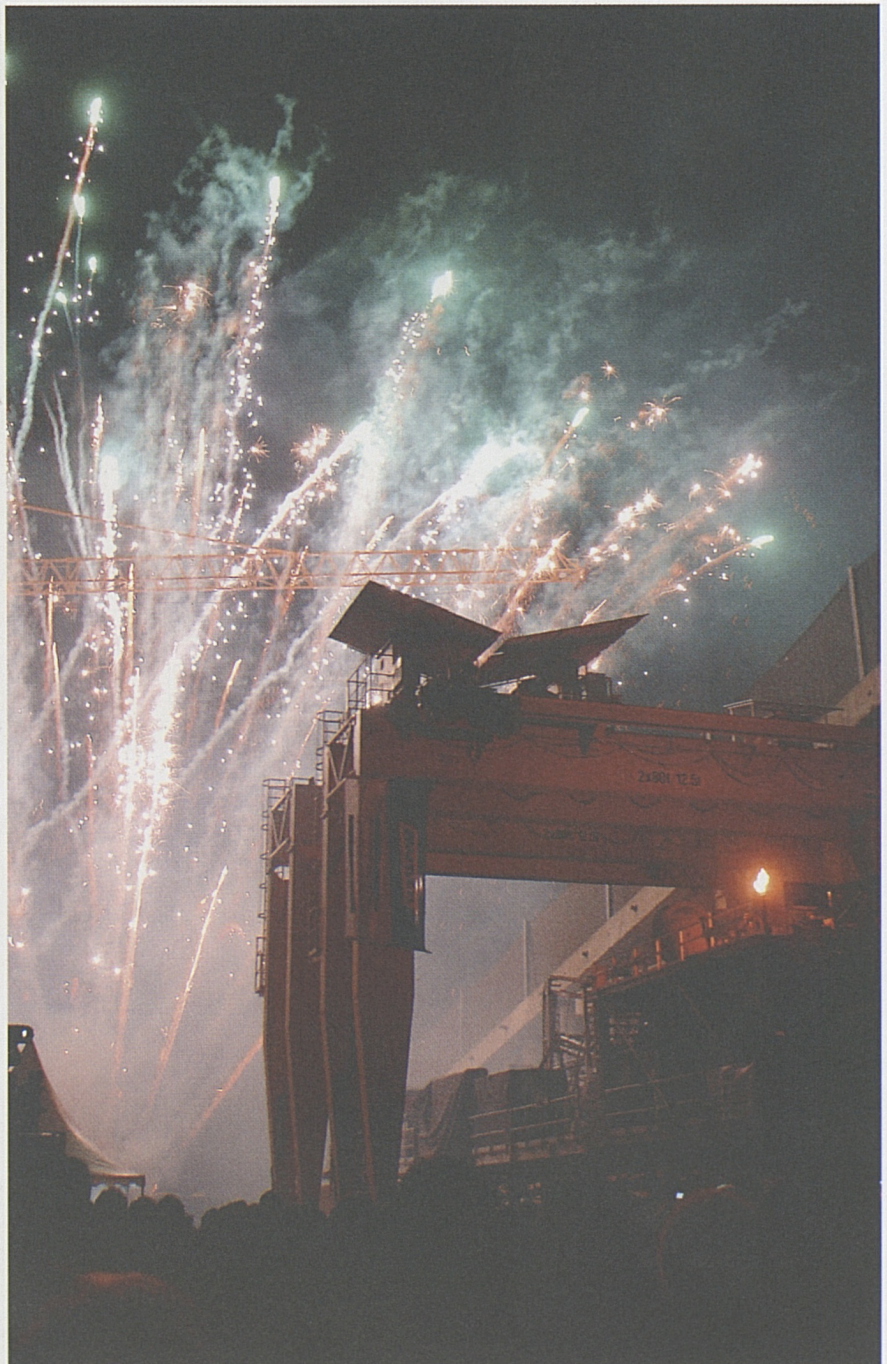
Feierlicher Beginn der letzten Etappe des Gotthard-Basistunnels.
