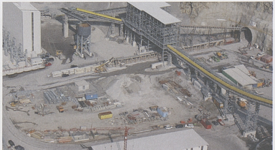
Luftaufnahme der Baustelle Sigirino mit dem Fensterstollen.
