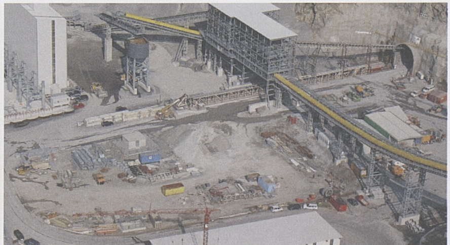
Luftaufnahme der Baustelle Sigirino mit dem Fensterstollen.
