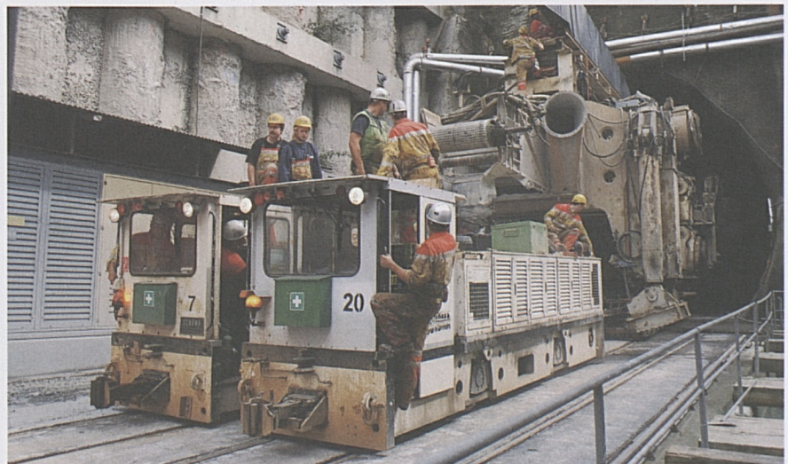
In einem eindrucklichen Konvoi verlässt die Rumpf-Tunnelbohrmaschine die Röhre.
