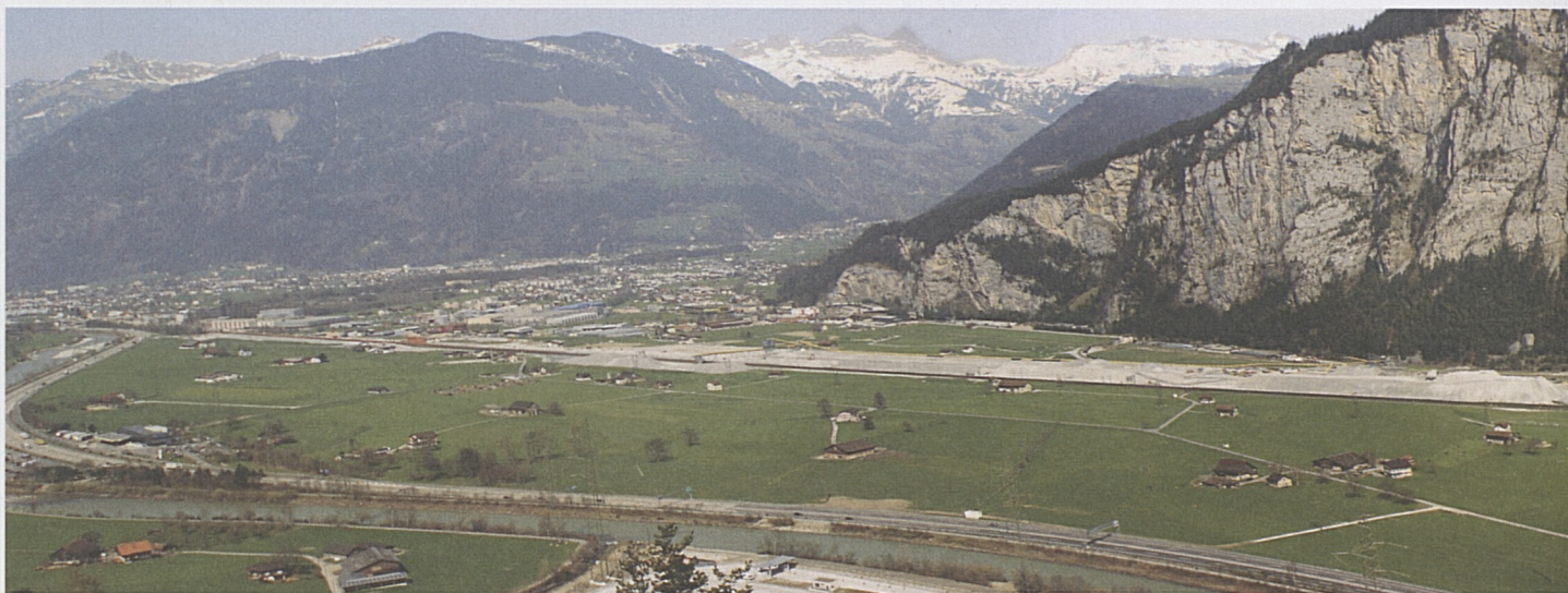
Reise durchs Reusstal: offene Strecke von Altdorf bis zur Baustelle Erstfeld.
