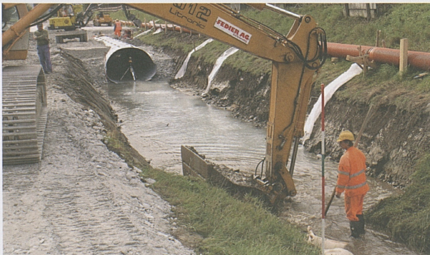
Das Fließgewässer Walenbrunnen wird aus dem engen Kanal befreit ...
