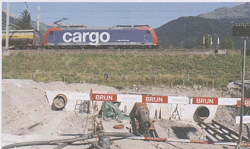
Zeitgemässe Verkehrsanbindung der Gemeinde Attinghausen: Vorbereitungsarbeiten für die Unterführung Wysshus.
