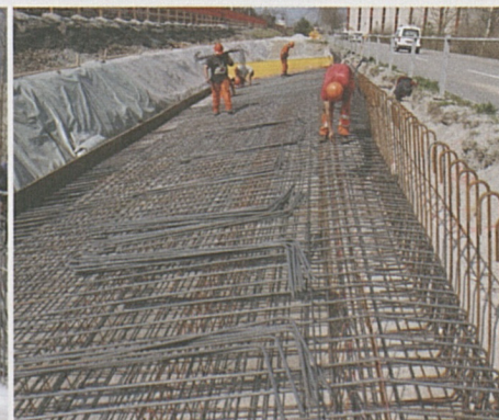
... über die Bewehrung des Fundamentes ...
