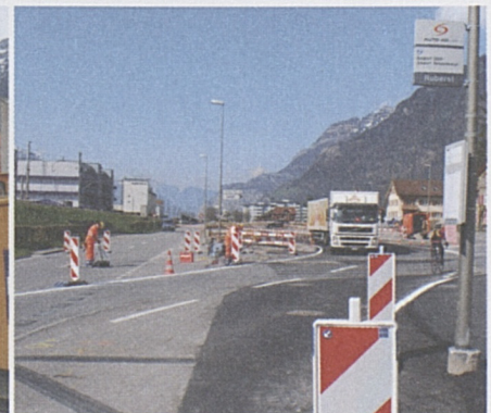
Strassenumlegung für den neuen Kreisell und die Unterführung Wysshus.
