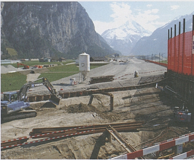
Aushubarbeiten für die neue Unterführung Riedstrasse.
