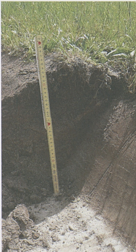
Kontrolle des Humusabtrags.
