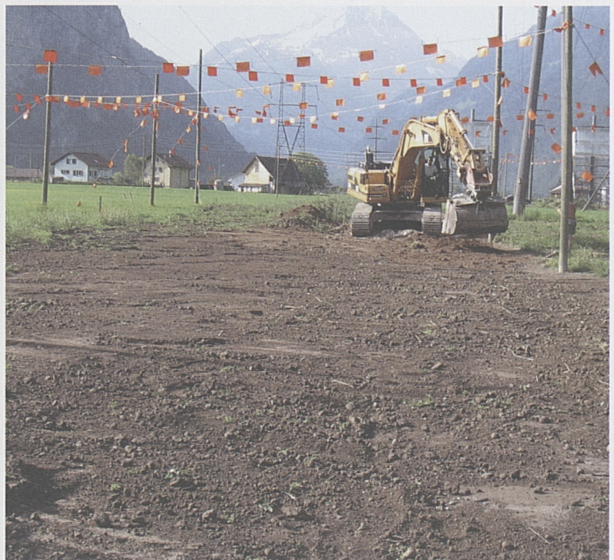
Rückbau der Baupisten, ohne dass der Boden direkt befahren werden muss.
