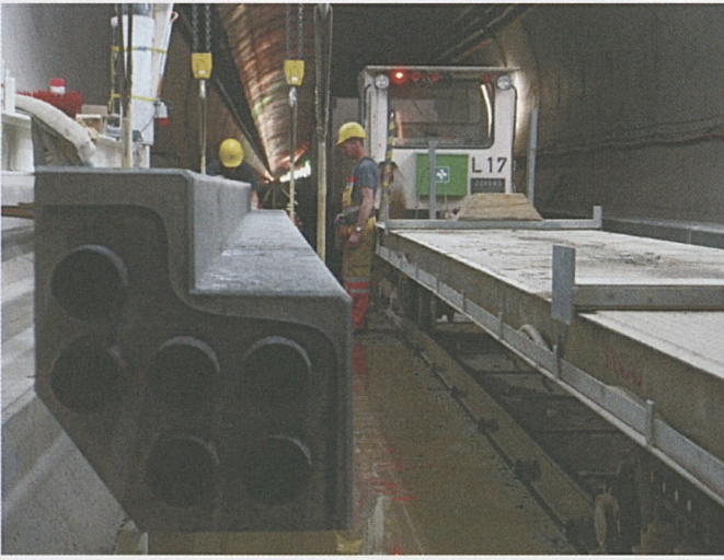
Amsteg Oströhre: Einbau der vorgefertigten Bankettelemente.
