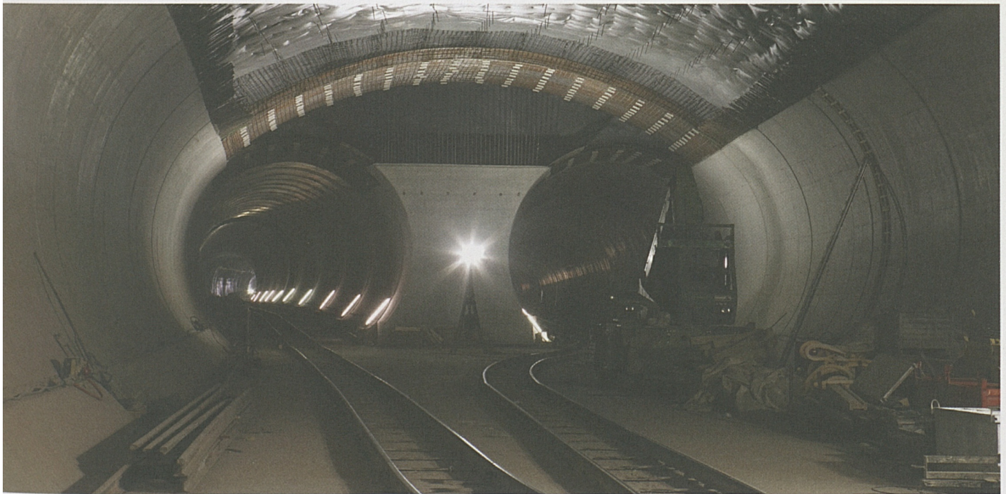
Tunnelwechsellaufweite in Sedrun: Eine riesige Fläche muss betoniert werden.
