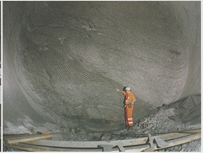
Faido Oströhre: Tunnelbrust mit Mineur mit dem Muster der Rollenmeissel an der Tunnelbrust.
