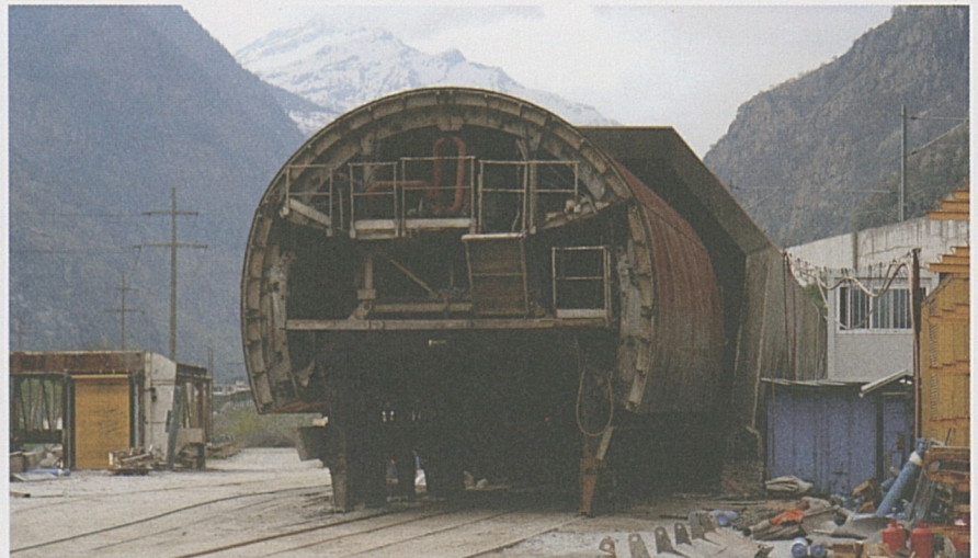
Bodio Portal Ost: Schalwagen Wurmino ist bereit zur Demontage.
