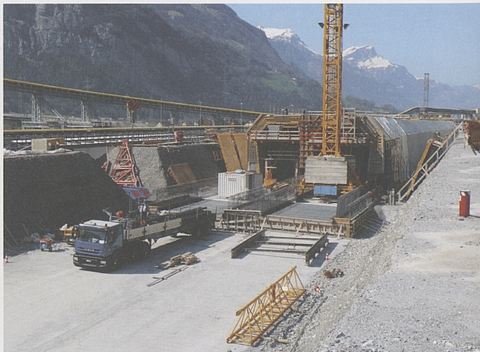
Eine eigene Baustelle auf Baustelle: Der Tagbautunnel wird von Norden nach Süden gebaut.
