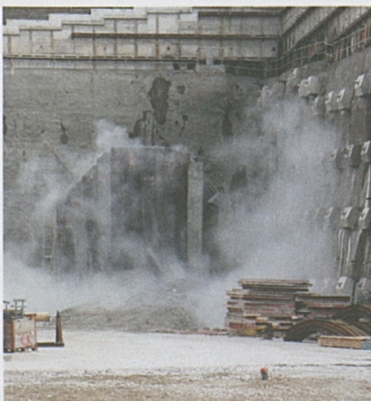
Erste Sprengung beim Südportal in Vezia.
