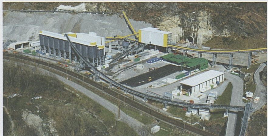
Die Baustelle des Ceneri-Basistunnels in Sigirino.
