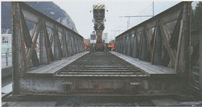
Die SBB-Brücke von 1882 wird mit einem 60-Tonnen Kran weggeführt.
