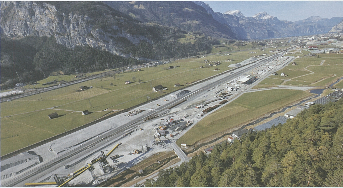
Auf 65 000 Quadratmetern entsteht im Rynächt der Bahntechnik-Installationsplatz: Hallen, Gleisanlagen und Bürogebäude.
