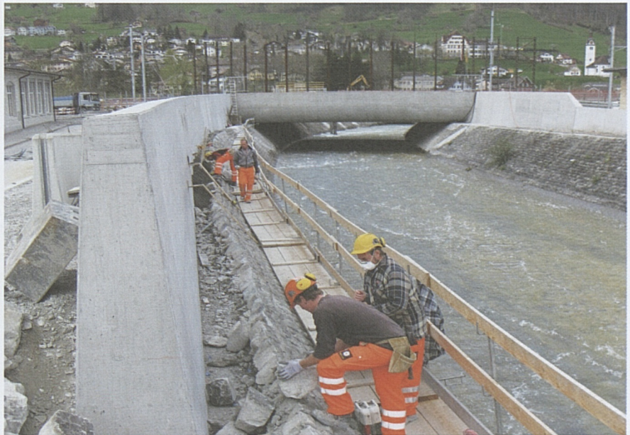
Druckbrücke über den Schächen mit den seitlichen Krügenmauern.
