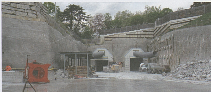
Das Südportal des Ceneri-Basistunnels in Vezia.
