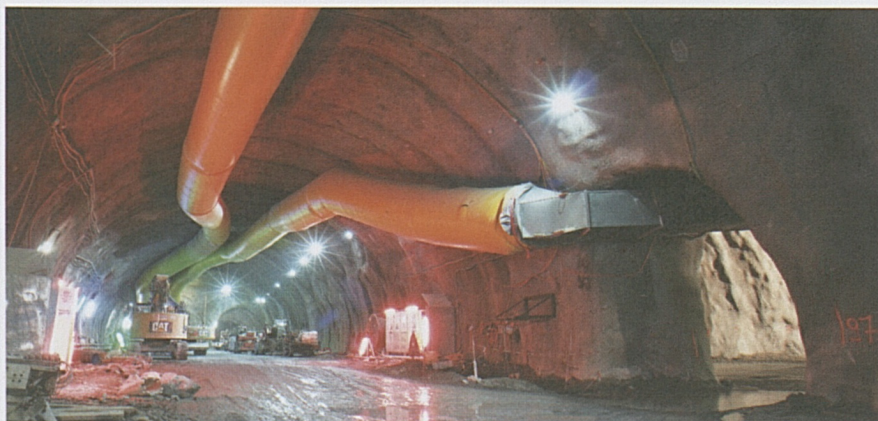
In der Westkaverne beim Nordportal des Ceneri-Basistunnels.
