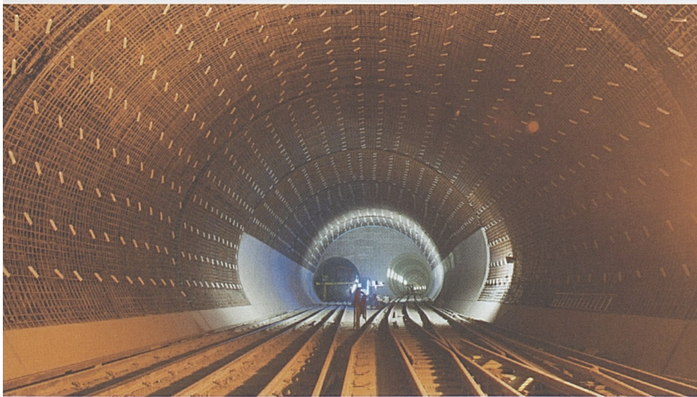
Faido: Armierte Tunnelwechsellaufweitung – bereit für die Betonarbeiten.
