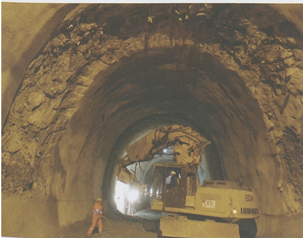
Vezia: Arbeiten in der Oströhre.
